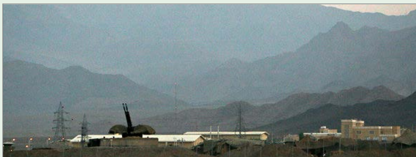
Ovan: Ett av målen för det israeliska flygvapnet. Inrättning för anrikning av uran i Natanz. Anläggningen försvaras av iranskt luftvärn och förmodas var skyddad under 30 meter armerad betong.
